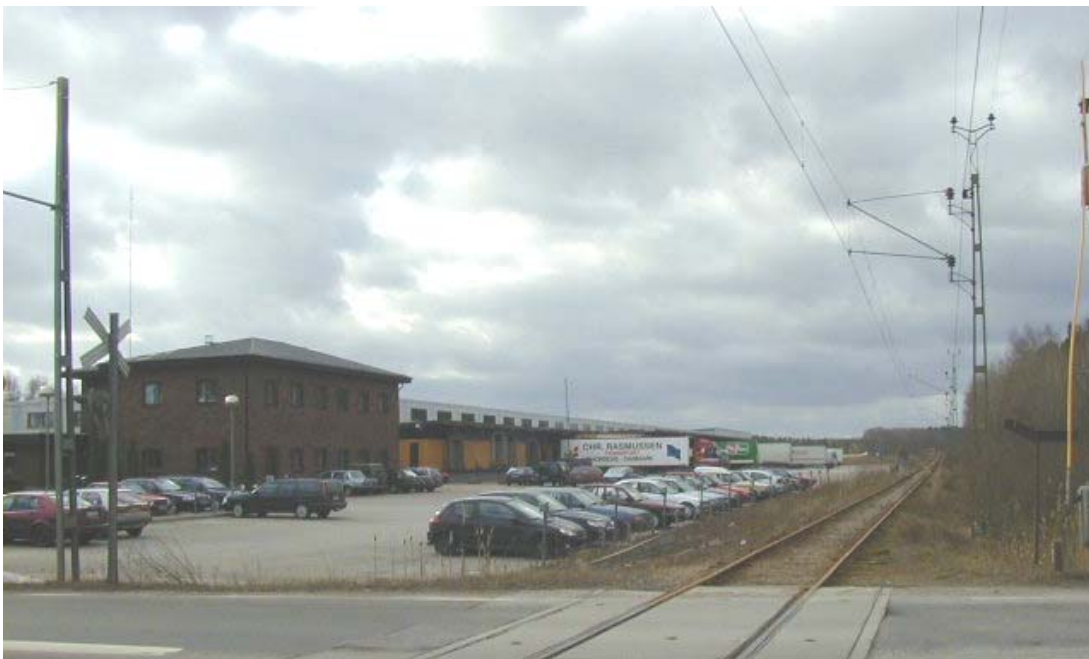
LBC. Plats för ny omlastningsplats mellan bil och tåg
