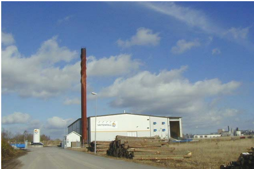
Vattenfalls fjärrvärmeverk på Baggebo industriområde
