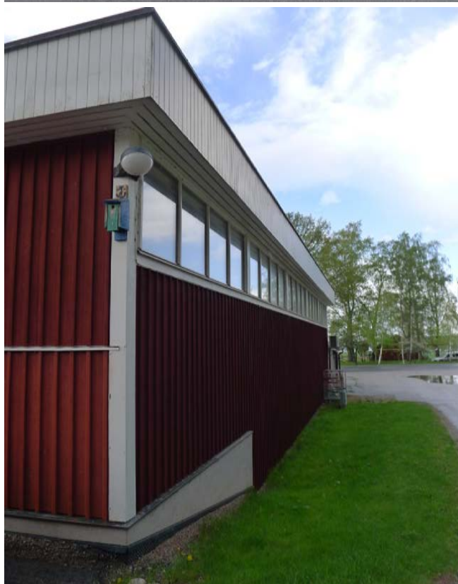
Fönster som sitter i kedjor på hus 2 och 3.
