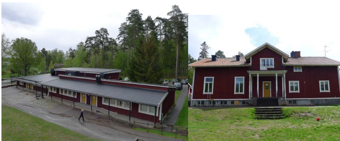
På hus 2 till 4 vetter alla entreer ut mot skolgården och dom sammanlänkas av det utstickande skärmtaket. Hus 1 har större fönster på den västra sidan av huset och större och aningen smalare fönster på den östra sidan. Detta är troligen ett resultat av ombyggnationer på 1930-talet.
