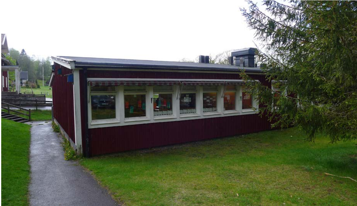
Fönster i rad på hus 4.
