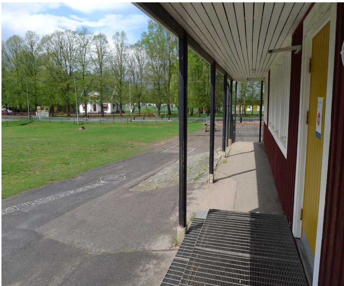
Gången under skärmtaket vid hus 4.
