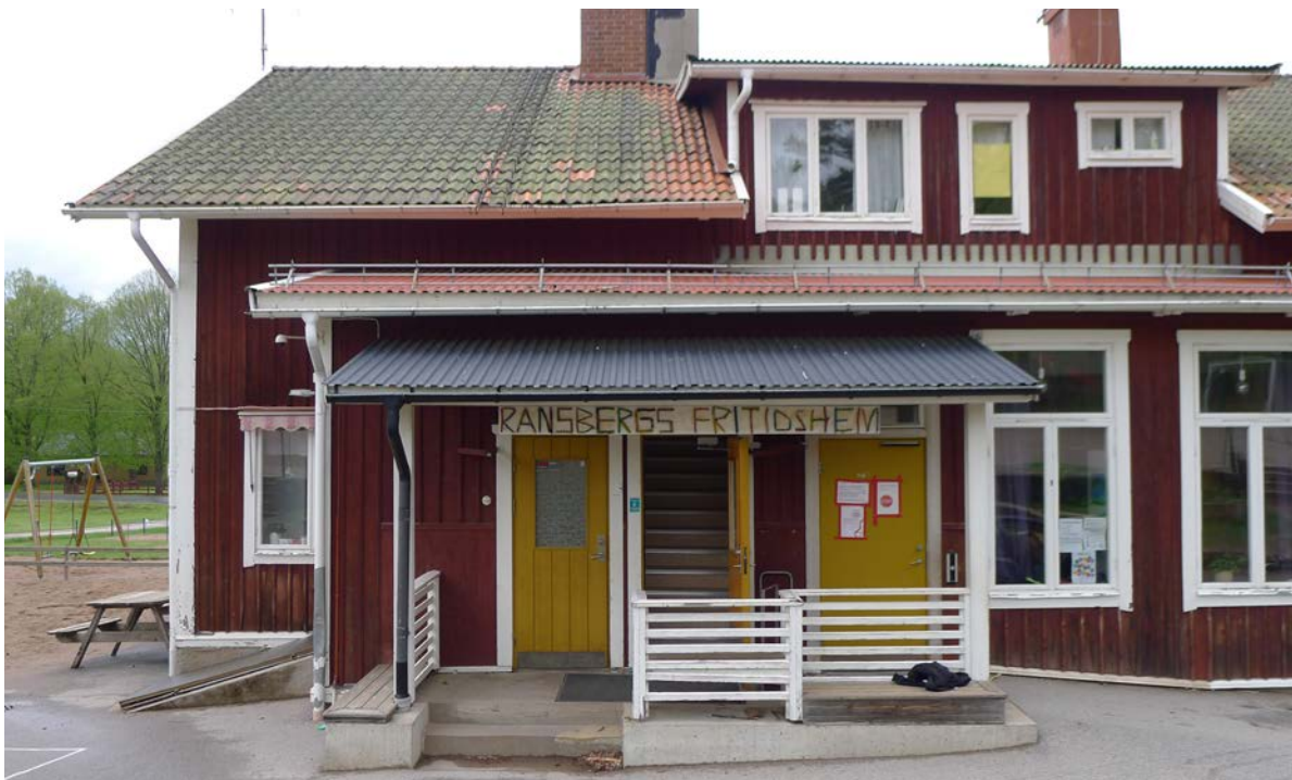
Utbyggt skärmtak, bildar som en modern farstukvist. Hus 1.
