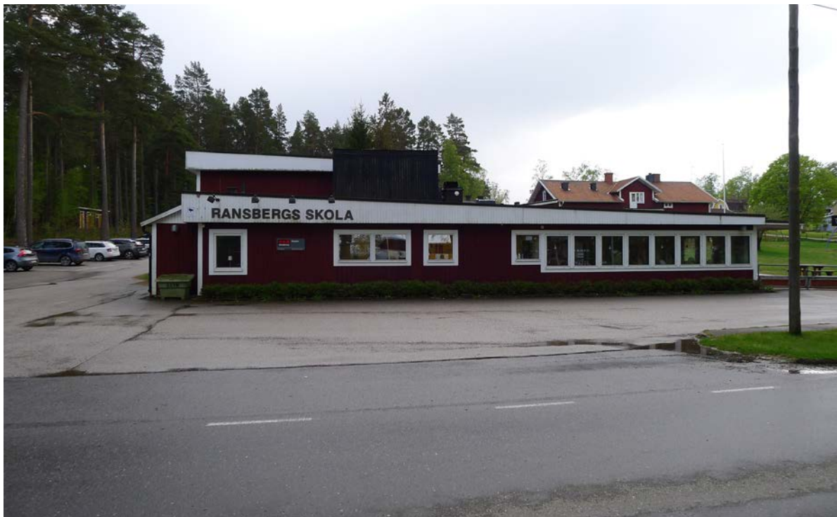
Hus 2 från norr.
