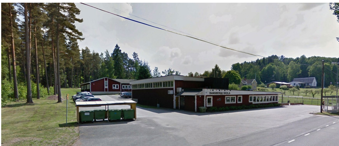
Befintlig skola från nordost.
