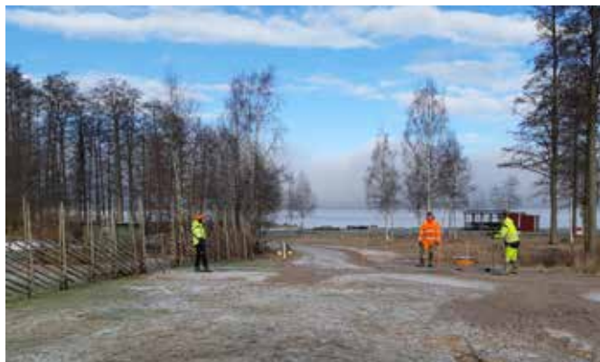
Arbetet med att bygga en 3,3 kilometer ny vattenledning mellan Bråbacka och Kylvånäs, som påbörjades hösten 2020, slutfördes under året. Foto: Jacob Ingelsson
