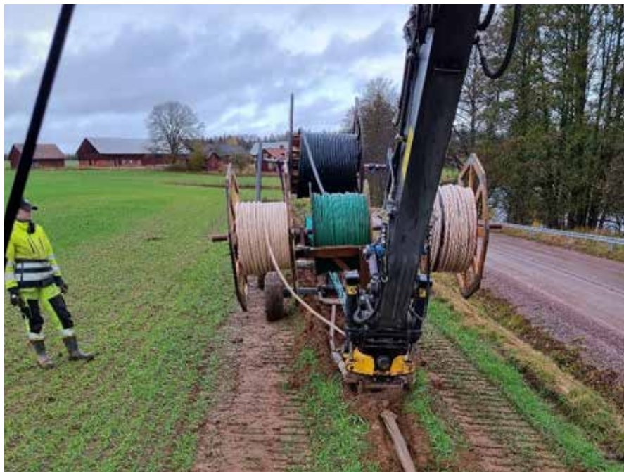
Under året har Tibro Elnät satt upp tre nya nätstationer och 50 kabelskåp. Tre inomhusbetjänade nätstationer har försetts med nya ställverk och transformatorer och fyra större kabelprojekt har genomförts. På bilden till vänster pågår fiberdragning i Västra Torsrud och på bilden ovan ses den nyinstallerade nätstationen på Ångsätragatan. Foto: Tibro Elnät AB
