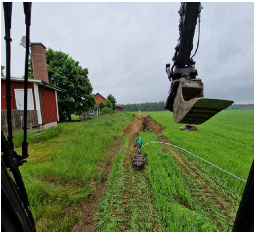
Under året har utbyggnaden av fibernätet på landsbygden fortsatt. På bilderna ser vi förläggning av fiberkanalisation för stamnät samt förläggning av kanalisation till en fastighet i projektet VästerHönsa. Foto: Tibro Elnät AB
