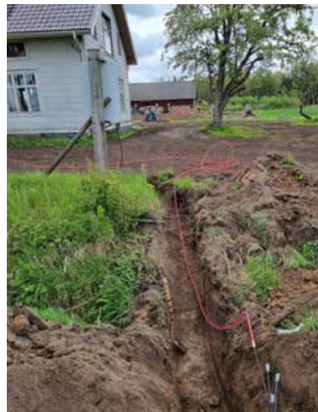
Under året har utbyggnaden av fibernätet på landsbygden fortsatt. På bilderna ser vi förläggning av fiberkanalisation för stamnät samt förläggning av kanalisation till en fastighet i projektet VästerHönsa. Foto: Tibro Elnät AB
