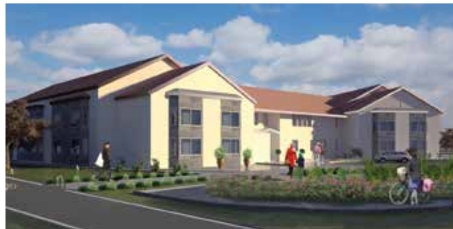
Under 2016 påbörjades byggnationen av ett nytt äldreboende och två flerbostadshus med totalt 38 lägenheter i kvarteret Örnen. Illustration: Linkarkitektur
