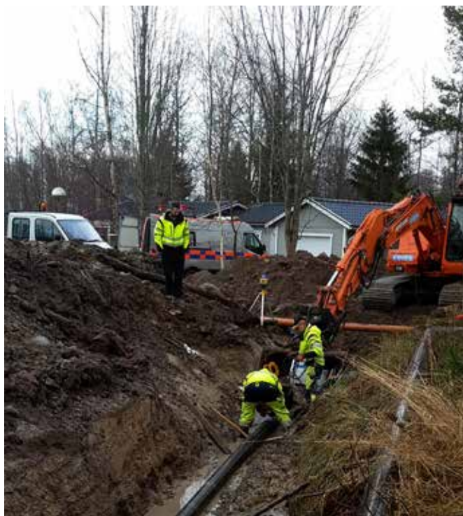
Våren 2016 byttes en problemfylld del av tryckavloppsledningen i sommarstugeområdet Bråbacka ut. Foto: Johan Larsaeus
