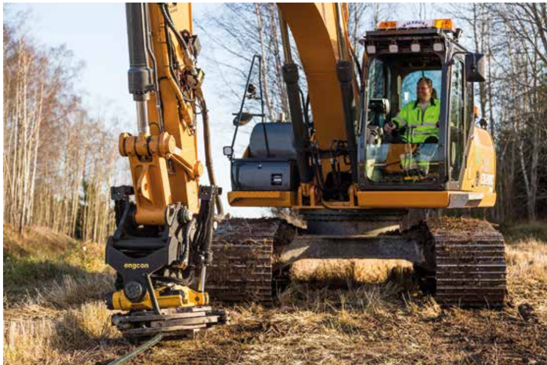
Under året har cirka 14 kilometer luftledningars söder om Tibro tagits ner och ersatts med jordkabel. Foto: Tibro Elnät
