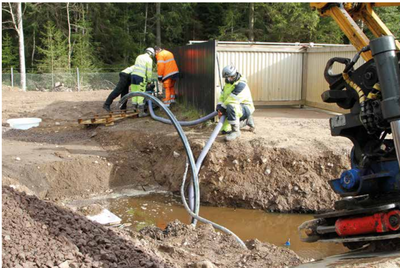
Arbetet med att ansluta Tibro Motorstadion till det kommunala vatten- och avloppsledningsnätet inleddes den 21 januari och var färdigt i månadsskiftet februari-mars, då systemet som ska styra pumpningen av avloppsvatten från stadion till reningsverket installerades. Foto: Christina Froh
