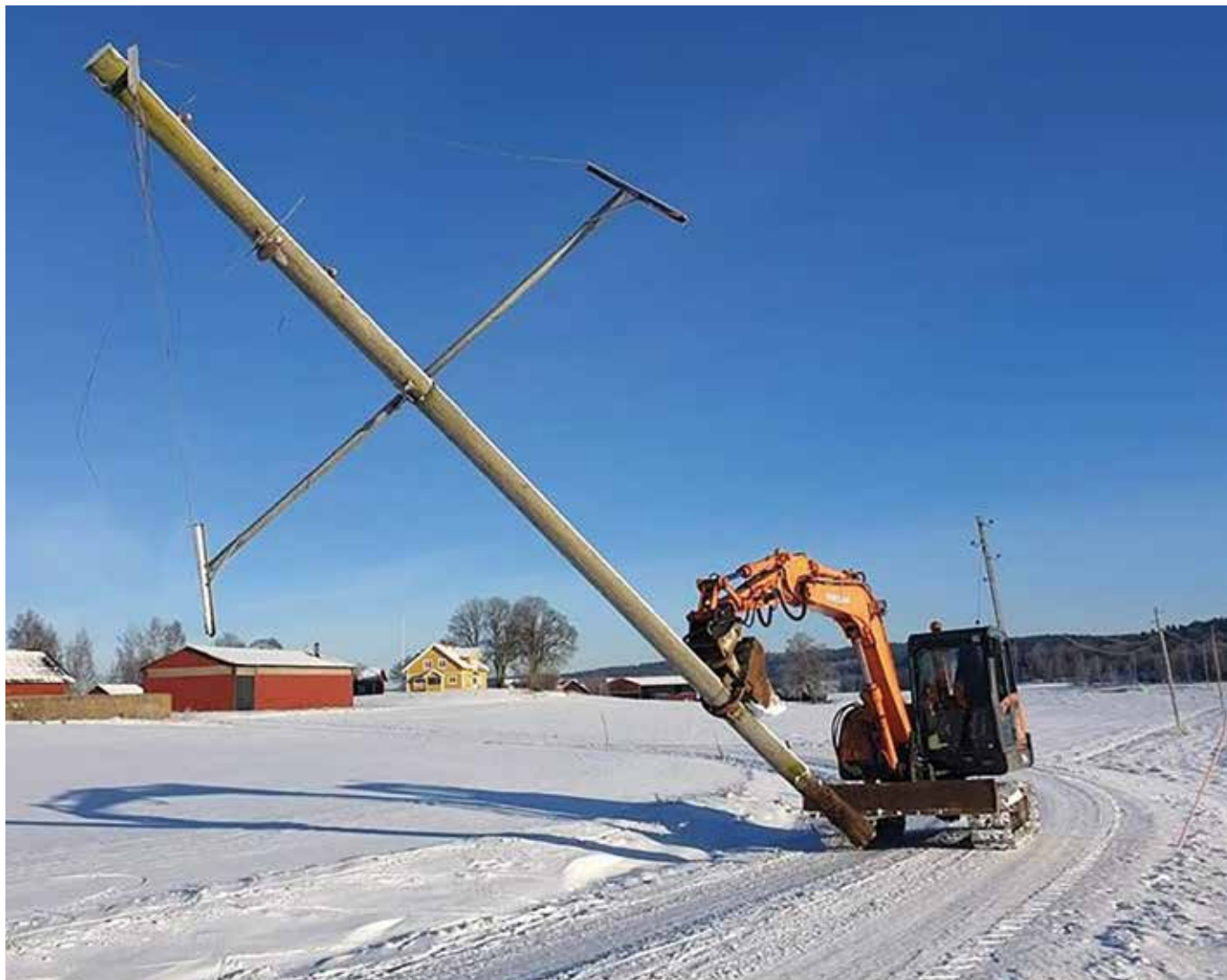
Under 2020 togs en luftledning i Kateryd, som tidigare matat fram el till vattenverket i Karlshaga, bort. Foto: Tibro Elnät AB
